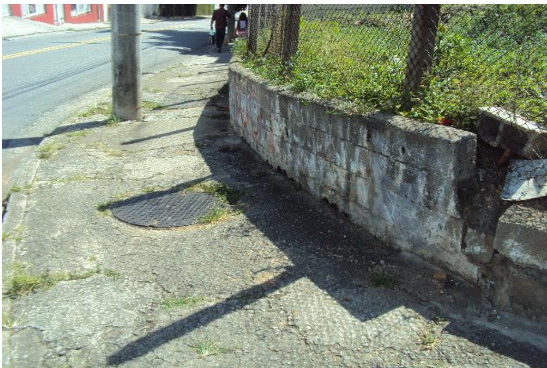
FOTO Nº 09 – Vista da testada do terreno, em curva.
